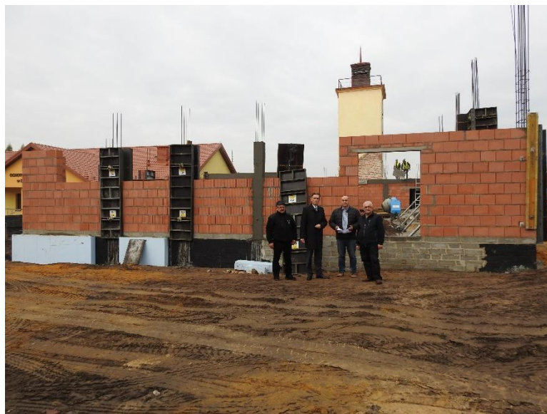
Budowa strażnicy w Dąbrowie nad Czarną
