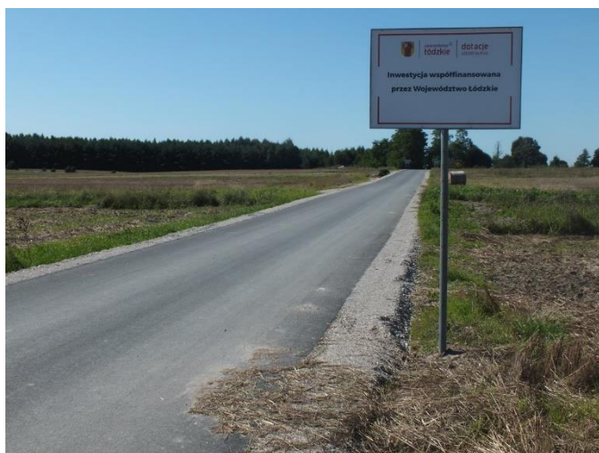
Remont drogi w miejscowości Reczków Nowy
